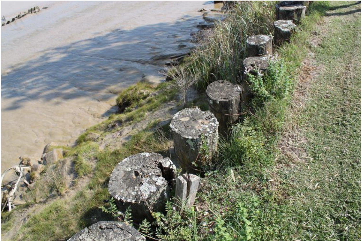
Pieux stabilisant la digue.
