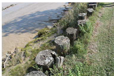
Pieux stabilisant la digue. Phot. Claire Steimer IVR72_20103303613NUCA
