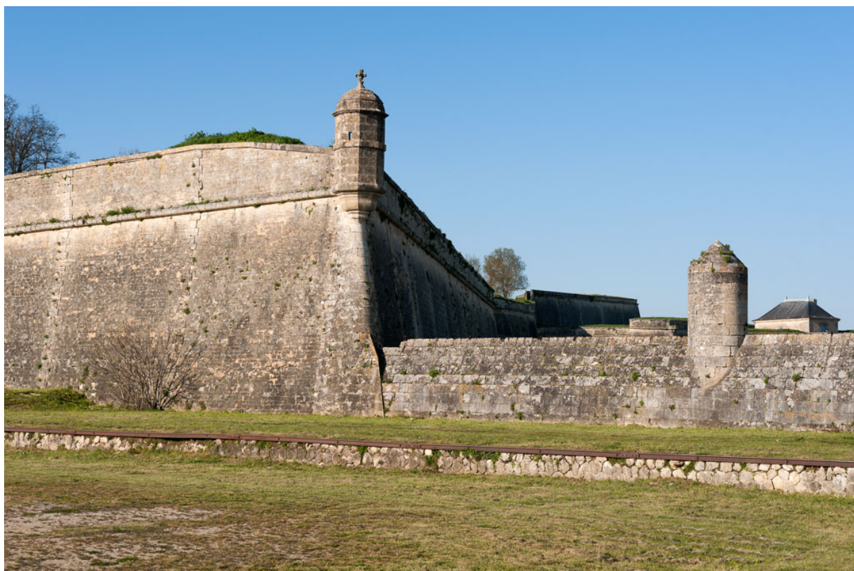
Vue du batardeau et du saillant du bastion du port depuis le sud.
