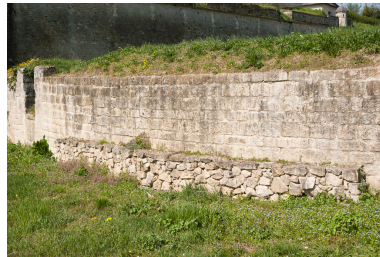
Bastion Saint-Romain : face interne du parapet du flanc nord. Phot. Adrienne Barroche IVR72_20113310759NUC4A
