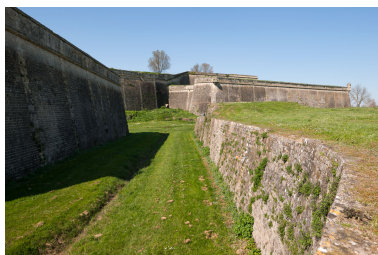
Vue du fossé de la demi-lune de la porte dauphine et bastion Saint-Romain depuis le sud. Phot. Adrienne Barroche IVR72_20113310674NUC4A
