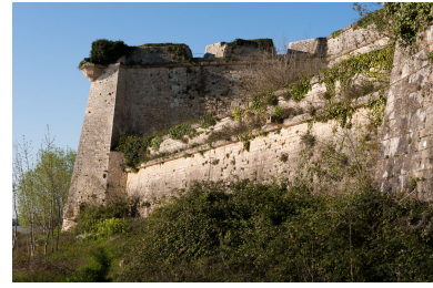
Vue de la batterie dite des matelots sur le front sud-ouest. Phot. Adrienne Barroche IVR72_20113310799NUC4A
