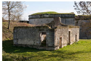
Bastion du château : corps de garde. Phot. Adrienne Barroche IVR72_20113310741NUC4A
