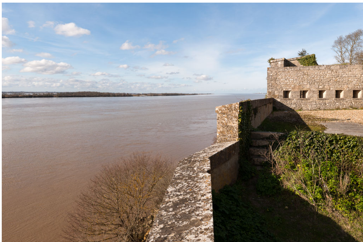
Ouvrage d'artillerie surmontant la caponnière du front du Cône, et vue vers l'estuaire au nord.
