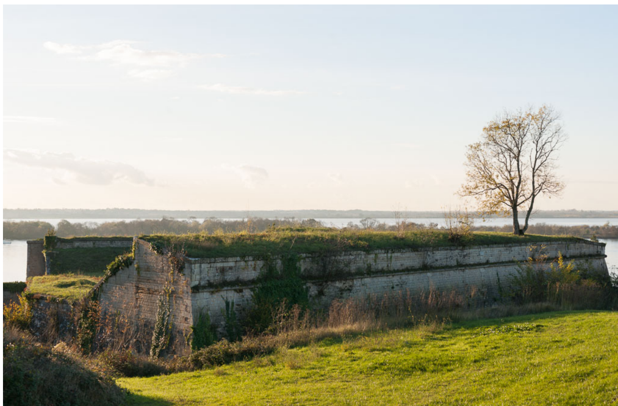
Vue d'ensemble du retranchement du Cône depuis l'est.
