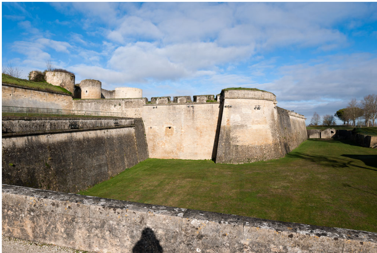
Vue d'ensemble de l'ouvrage avancé intégré dans le bastion, depuis le sud.
