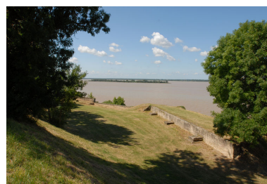
Vue sur l'estuaire vers l'île Paté depuis le chemin de ronde à l'ouest. Phot. Michel Dubau IVR72_20093300168NUC2A
