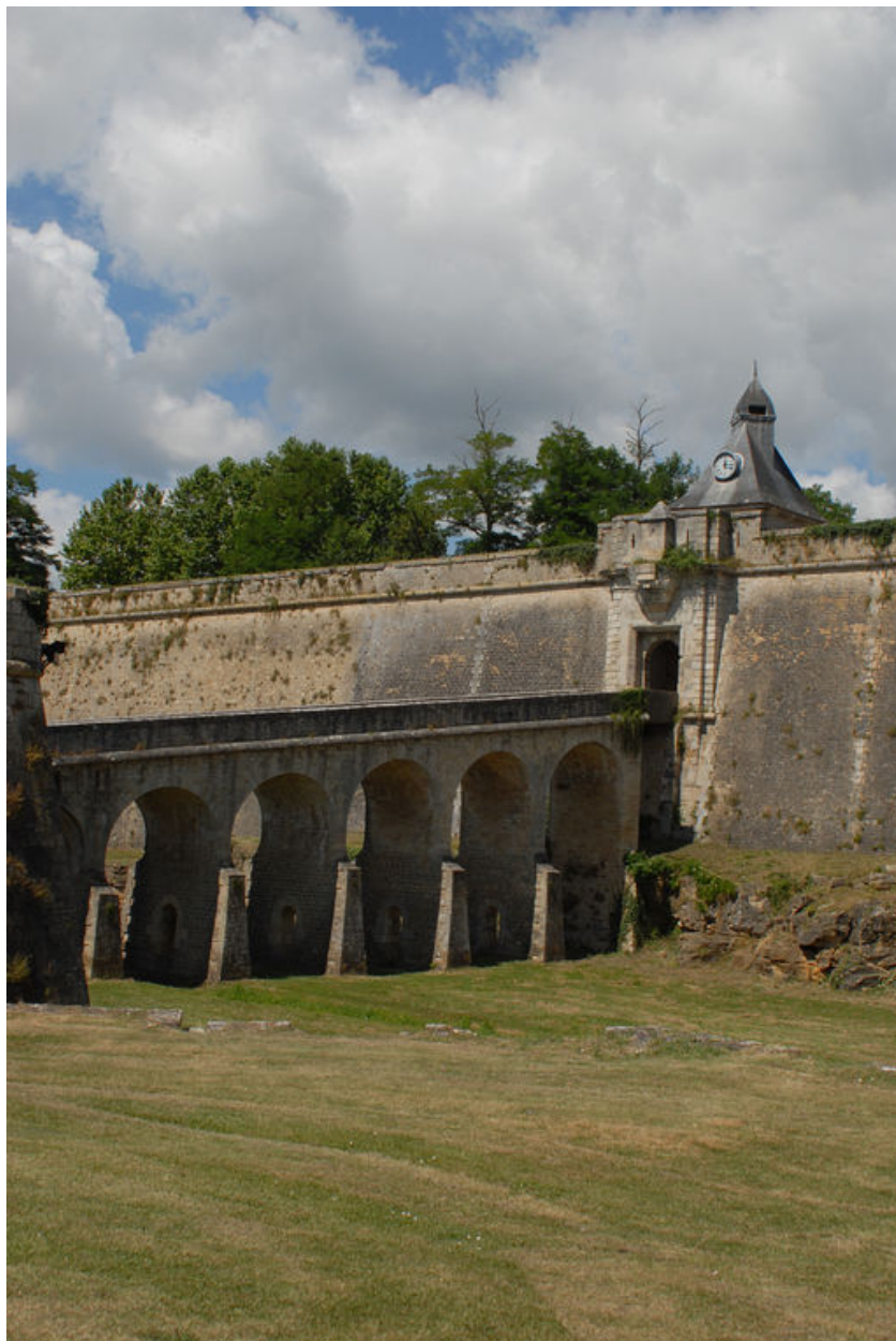
Pont sur le fossé face à la porte dauphine, vu du nord.
