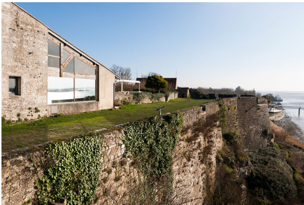
Escarpement rocheux face à l'estuaire, dans le secteur du couvent des Minimes.
