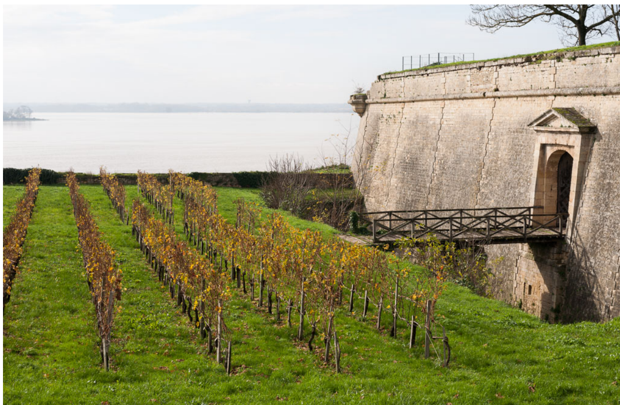
Bastion du Port : pont-levis et porte dans la courtine.
