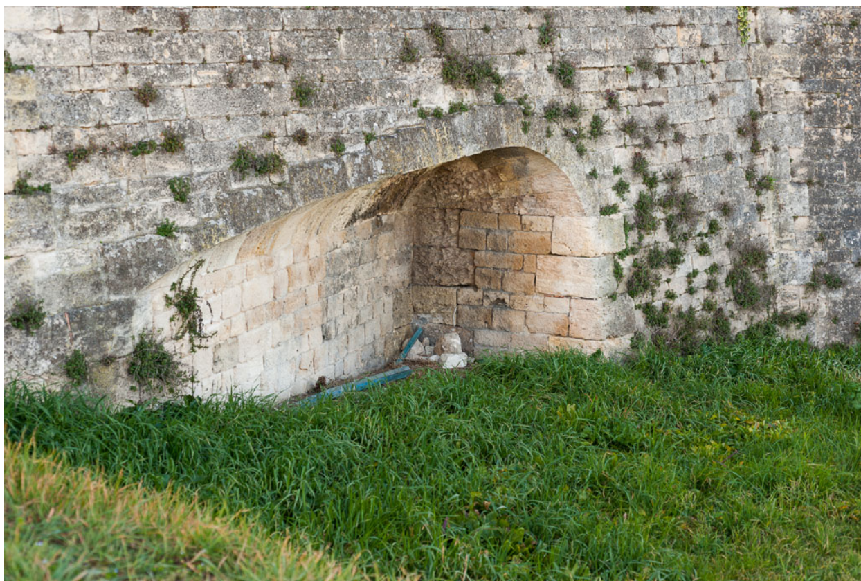
Courtine du bastion Saint-Romain : détail de la maçonnerie.
