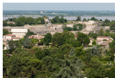
Vue depuis le sommet du château d'eau de Touvent vers la citadelle à l'ouest. Phot. Adrienne Barroche IVR72_20123310592NUC4A
