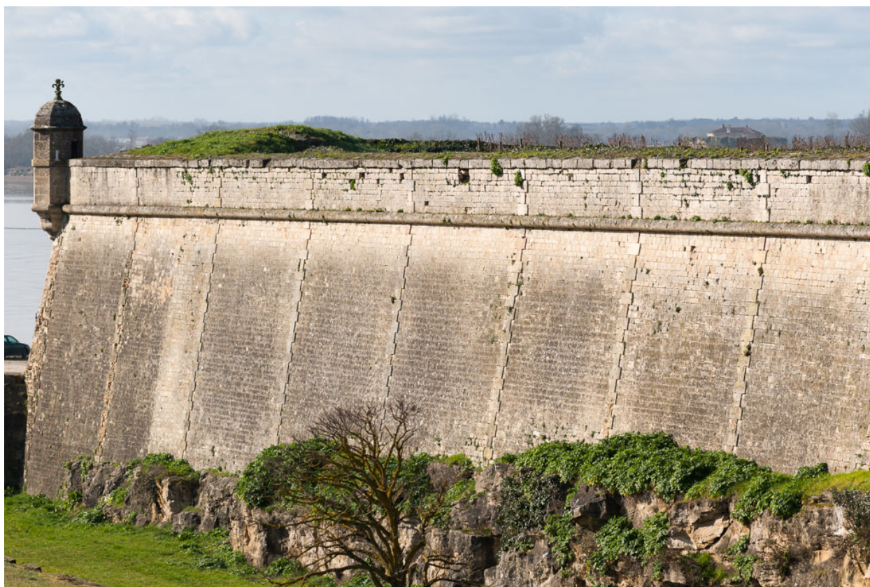
Bastion du Port : front est.
