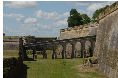
Fossé et pont reliant la demi-lune à la porte dauphine, vus du nord. Phot. Michel Dubau IVR72_20093300189NUC2A
