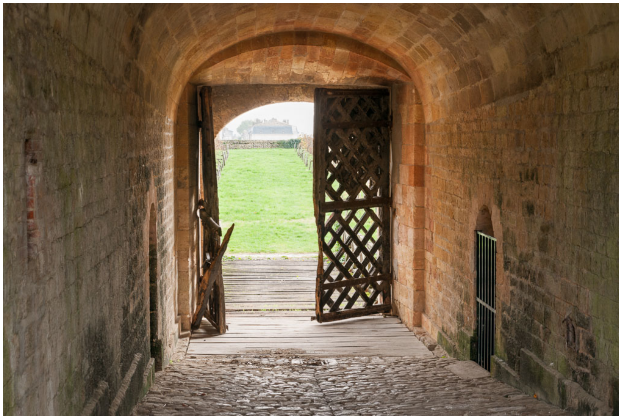
Bastion du port : corps de passage de la porte dans la courtine.
