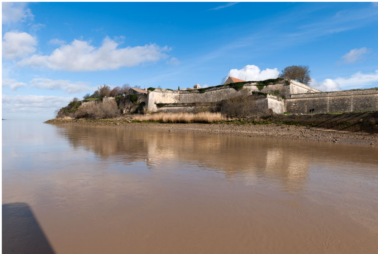
Vue d'ensemble du front côté estuaire depuis le ponton au sud-ouest.
