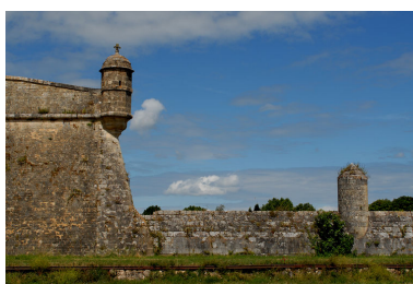
Batardeau doté d'une dame fermant le fossé du bastion du port. Phot. Michel Dubau IVR72_20093300202NUC2A
