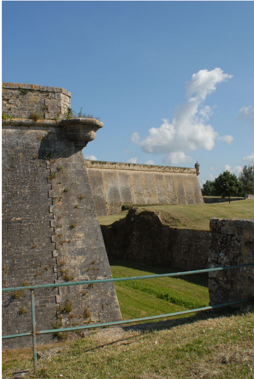
Angle flanqué de la demi-lune de la porte dauphine et flanc sud du bastion Saint-Romain.
