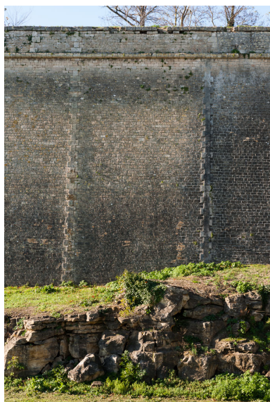
Détail de la courtine entre la porte dauphine et le bastion du port. Phot. Adrienne Barroche IVR72_20113310669NUC4A
