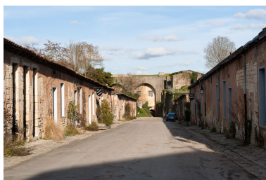
Vue selon l'axe ouest-est vers la porte Saint-Romain. Phot. Adrienne Barroche IVR72_20113310610NUC4A
