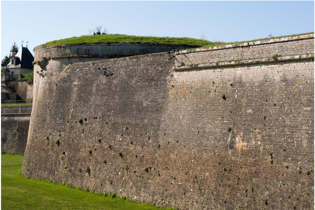
Bastion du château : jonction entre la courtine du front est et le fer à cheval.
