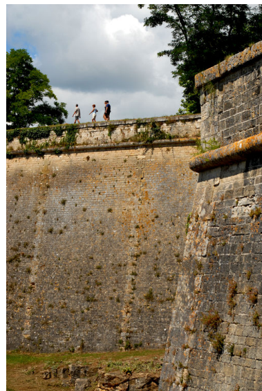
Pan de courtine entre la demi-lune de la porte dauphine et le bastion du port. Phot. Michel Dubau IVR72_20093300197NUC2A
