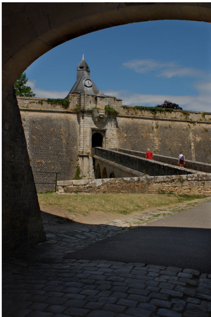
Vue de la porte dauphine depuis le corps de passage de la demi-lune.
