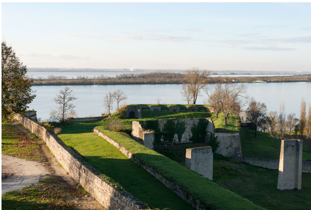
Vue du bastion du Cône depuis le sud-est, avec l'estuaire et l'île Nouvelle au fond.
