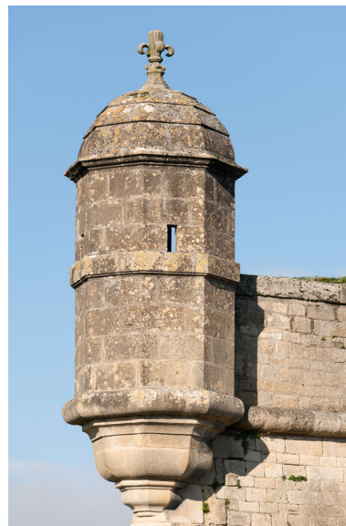
Bastion du port : détail de l'échauguette. Phot. Adrienne Barroche IVR72_20113310661NUC4A
