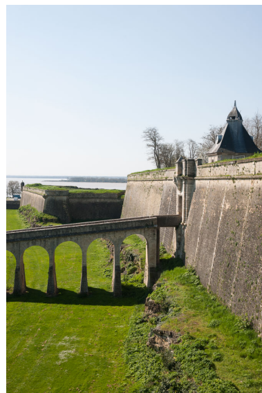
Courtine dans le secteur de la porte dauphine et pont sur le fossé. Phot. Adrienne Barroche IVR72_20113310646NUC4A
