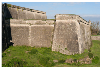
Bastion Saint-Romain : flanc sud. Phot. Adrienne Barroche IVR72_20113310675NUC4A
