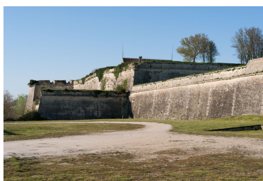
Front ouest du bastion du port et de la citadelle face à l'estuaire. Phot. Adrienne Barroche IVR72_20113310664NUC4A
