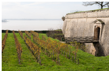
Bastion du Port : pont-levis et porte dans la courtine. Phot. Adrienne Barroche IVR72_20113310684NUC4A
