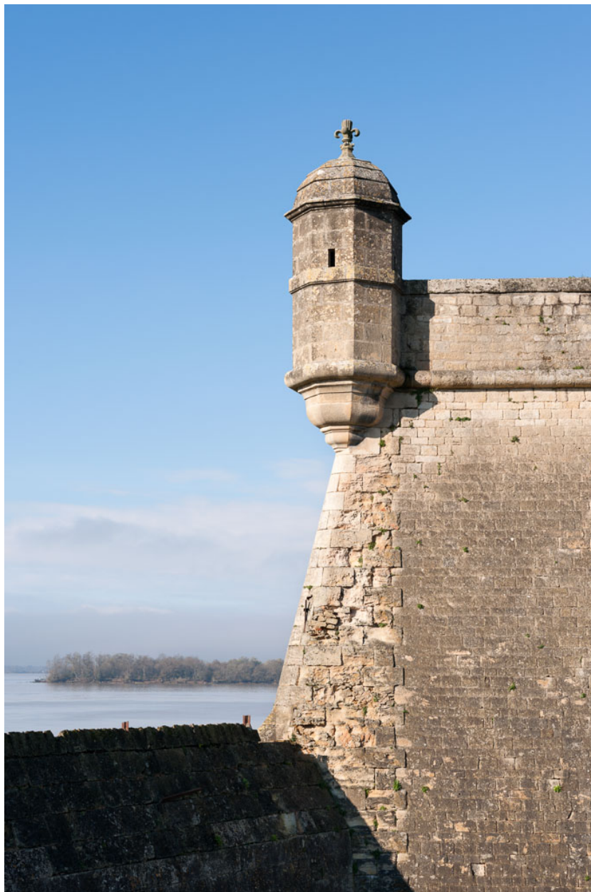
Saillant du bastion du port avec son échauguette.
