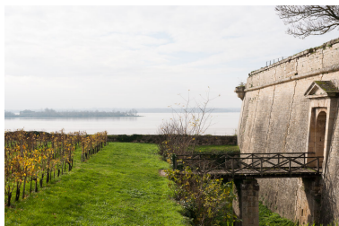
Bastion du Port : pont et porte dans la courtine, avec l'estuaire à l'arrière-plan. Phot. Adrienne Barroche IVR72_20113310685NUC4A
