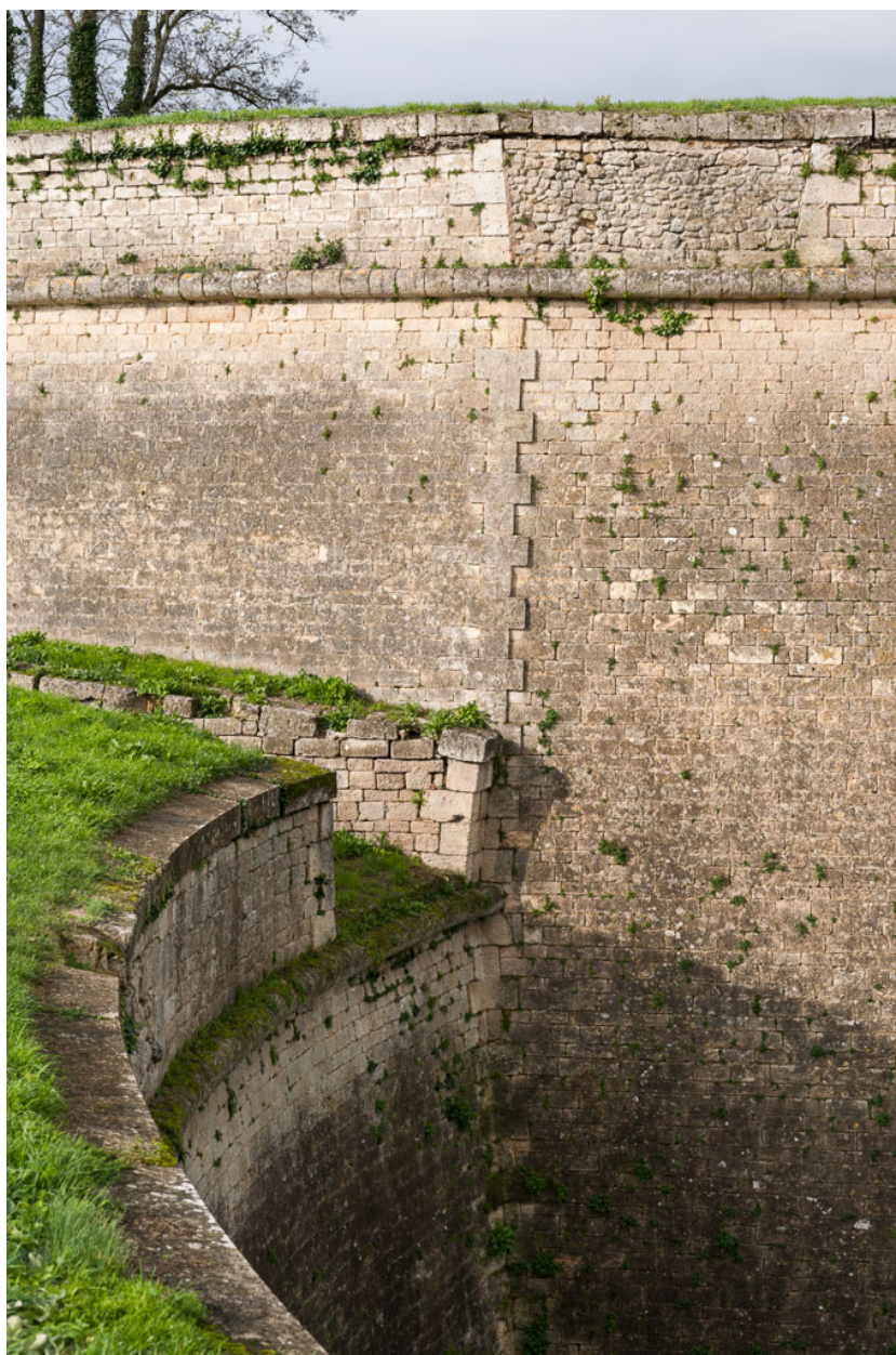
Flanc nord du bastion du port et courtine.
