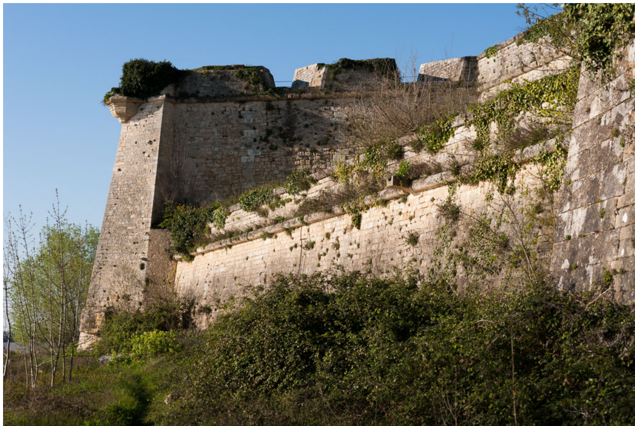
Vue de la batterie dite des matelots sur le front sud-ouest.
