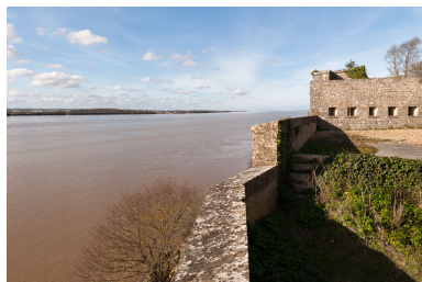
Ouvrage d'artillerie surmontant la caponnière du front du Cône, et vue vers l'estuaire au nord. Phot. Adrienne Barroche IVR72_20113310793NUC4A
