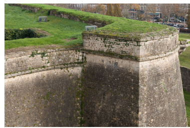
Bastion Saint-Romain : détail de l'orillon sud. Phot. Adrienne Barroche IVR72_20113310678NUC4A
