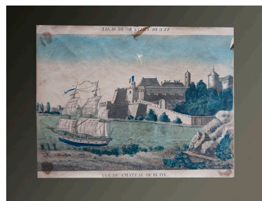
Vue du château de Blaye. Lithographie, s.d., 19e siècle (collection particulière). Phot. Michel Dubau IVR72_20123390317NUC2A
