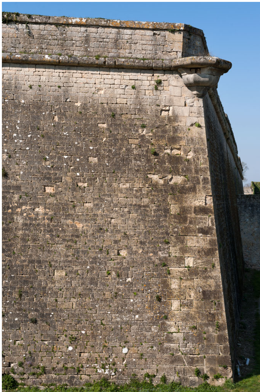
Bastion du château : vue du saillant depuis l'est.
