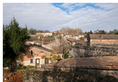
Vue depuis le sud du chemin de ronde de la porte dauphine vers le nord. Phot. Adrienne Barroche IVR72_20113310559NUC4A
