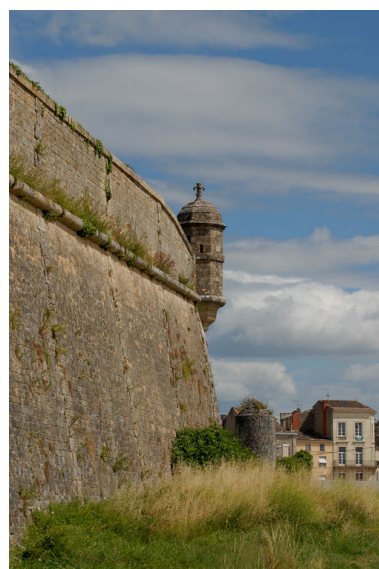
Flanc ouest du bastion du port et front de ville. Phot. Michel Dubau IVR72_20093300396NUC2A
