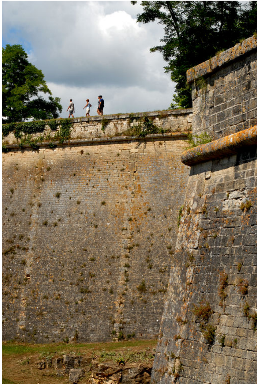
Pan de courtine entre la demi-lune de la porte dauphine et le bastion du port.
