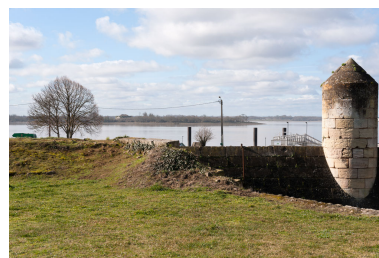
Batardeau sur le fossé du bastion du port : détail de la dame. Phot. Adrienne Barroche IVR72_20113310658NUC4A
