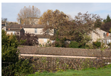
Vue depuis le chemin de ronde aux abords de la porte dauphine vers le nord. Phot. Adrienne Barroche IVR72_20113310558NUC4A
