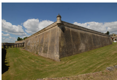
Angle flanqué du bastion Saint-Romain. Phot. Michel Dubau IVR72_20093300188NUC2A
