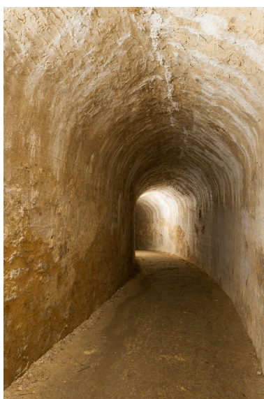
Couloir souterrain de liaison entre la poterne du bastion du château et la fausse-braie du côté du front du Cône au nord. Phot. Adrienne Barroche IVR72_20113310809NUC4A
