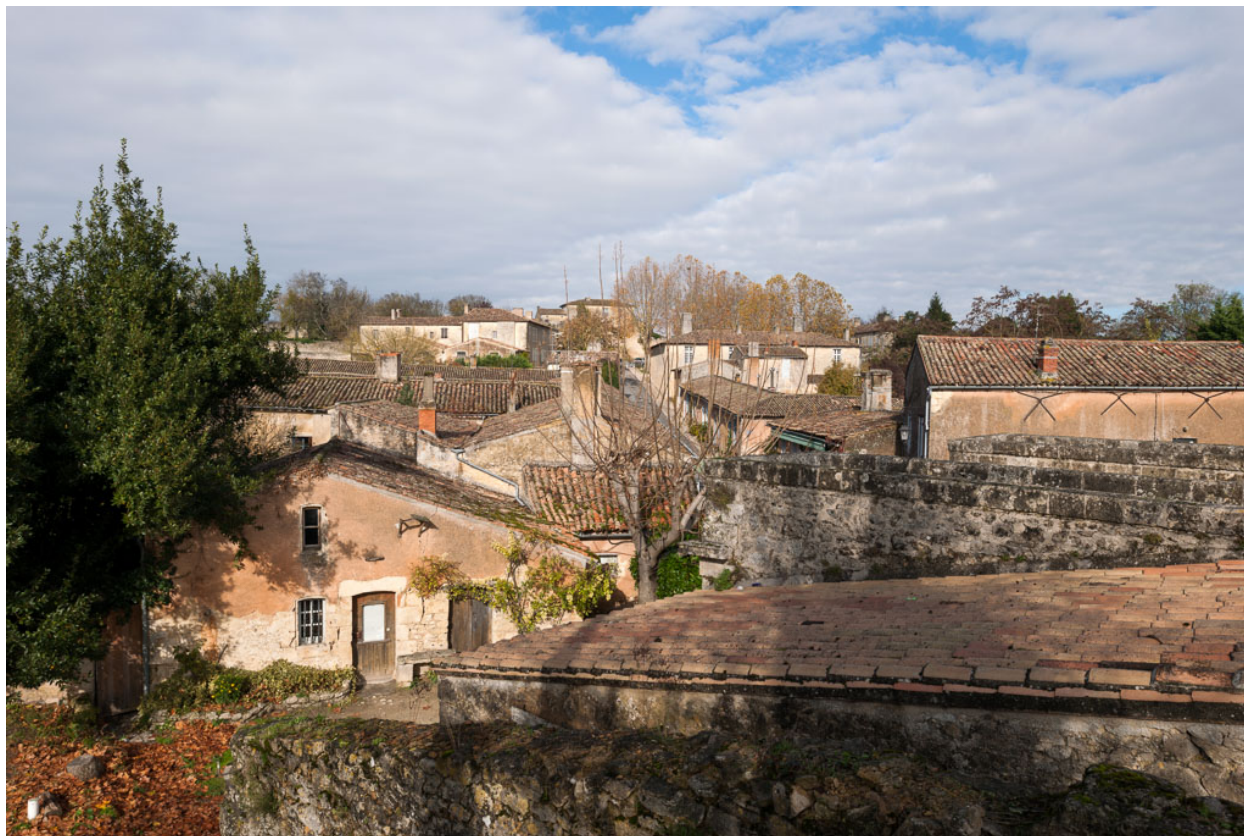
Vue depuis le sud du chemin de ronde de la porte dauphine vers le nord.
