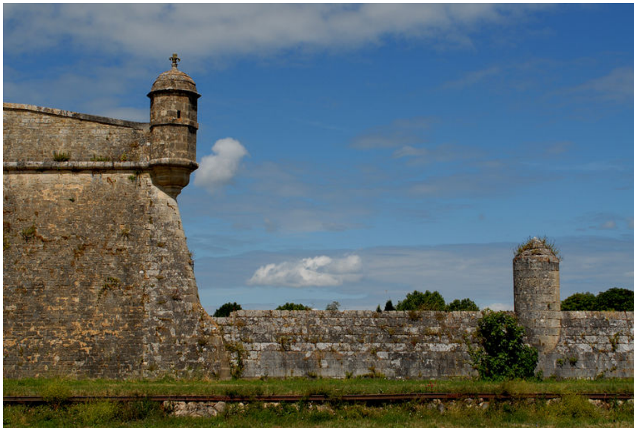
Batardeau doté d'une dame fermant le fossé du bastion du port.
