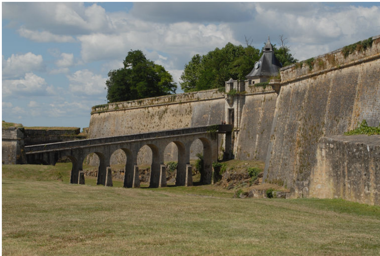
Pont sur le fossé face à la porte dauphine, vu du nord.
