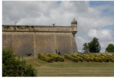
Vue du flanc sud du bastion Saint-Romain depuis la ville. Phot. Michel Dubau IVR72_20093300201NUC2A
