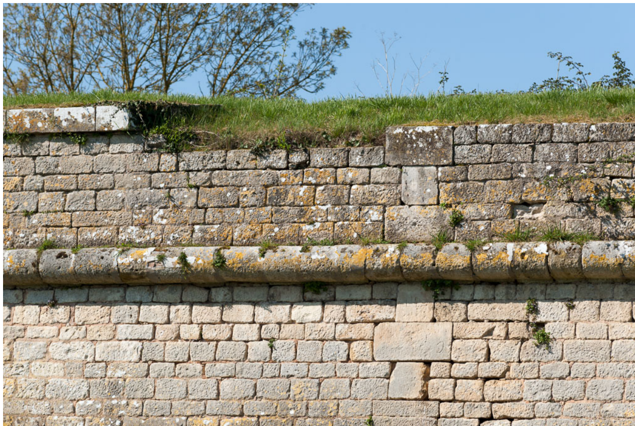
Bastion du château : front est, détail du parapet.
