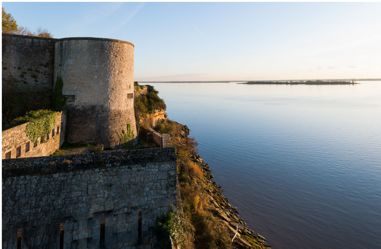
Tour de l'Eguillette avec l'ouvrage d'artillerie attenant, et vue vers l'estuaire au sud.
