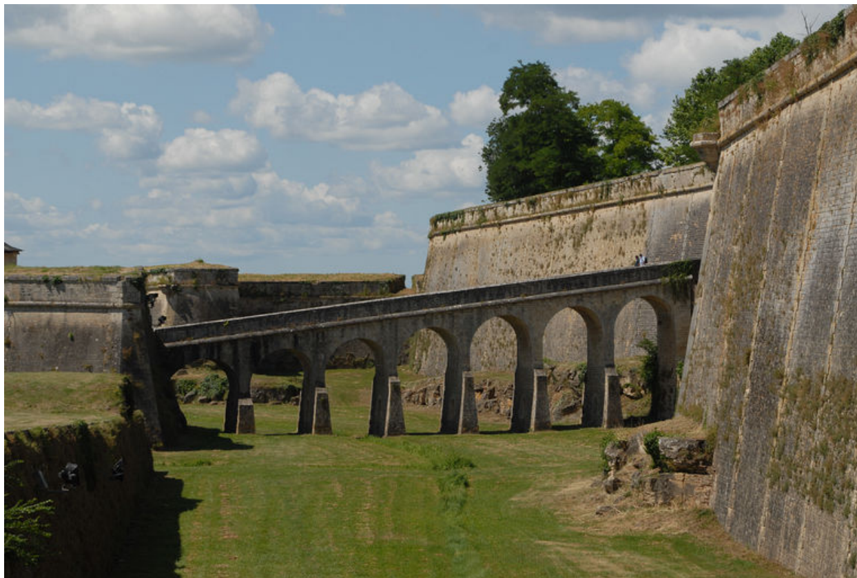
Fossé et pont reliant la demi-lune à la porte dauphine, vus du nord.
