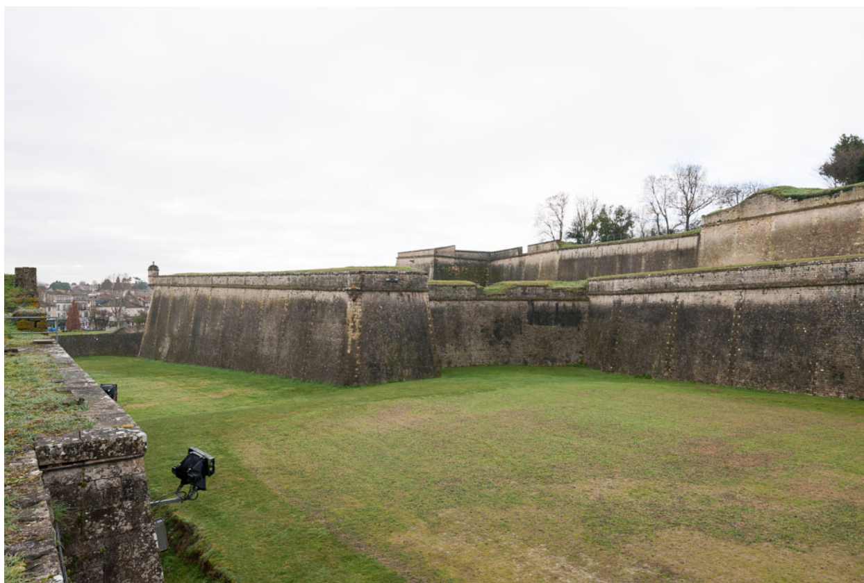
Vue du bastion du port depuis le nord-est.
