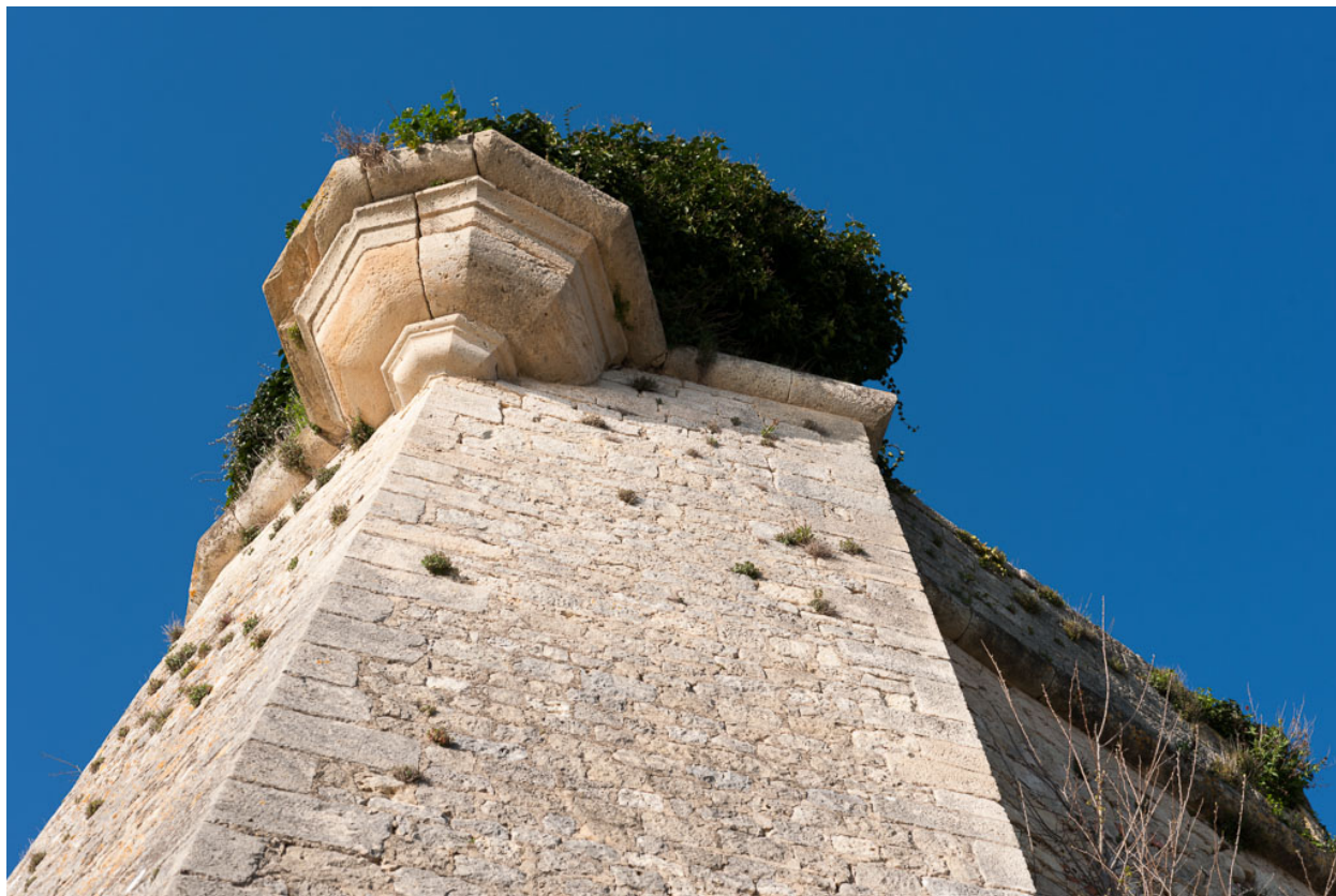
Saillant face à l'estuaire de la batterie dite des matelots : détail.
