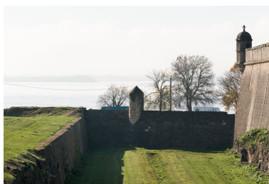
Batardeau sur le fossé du bastion du port. Phot. Adrienne Barroche IVR72_20113310657NUC4A
