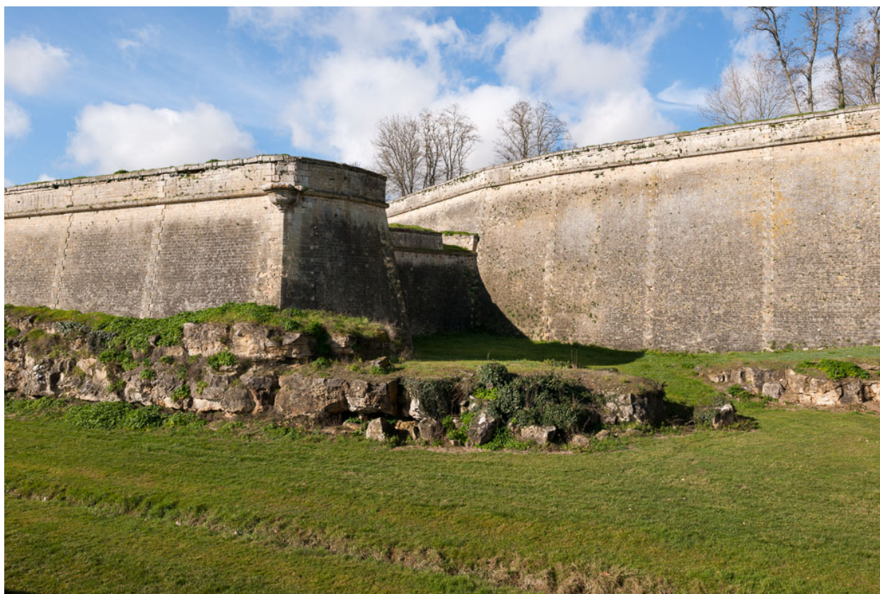
Courtine et jonction avec le bastion du port.
