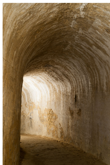
Couloir souterrain de liaison entre la poterne du bastion du château et la fausse-braie du côté du front du Cône au nord : détail. Phot. Adrienne Barroche IVR72_20113310810NUC4A
