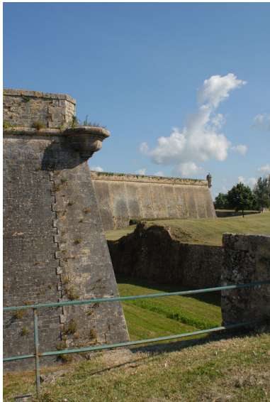
Angle flanqué de la demi-lune de la porte dauphine et flanc sud du bastion Saint-Romain. Phot. Michel Dubau IVR72_20093300152NUC2A
