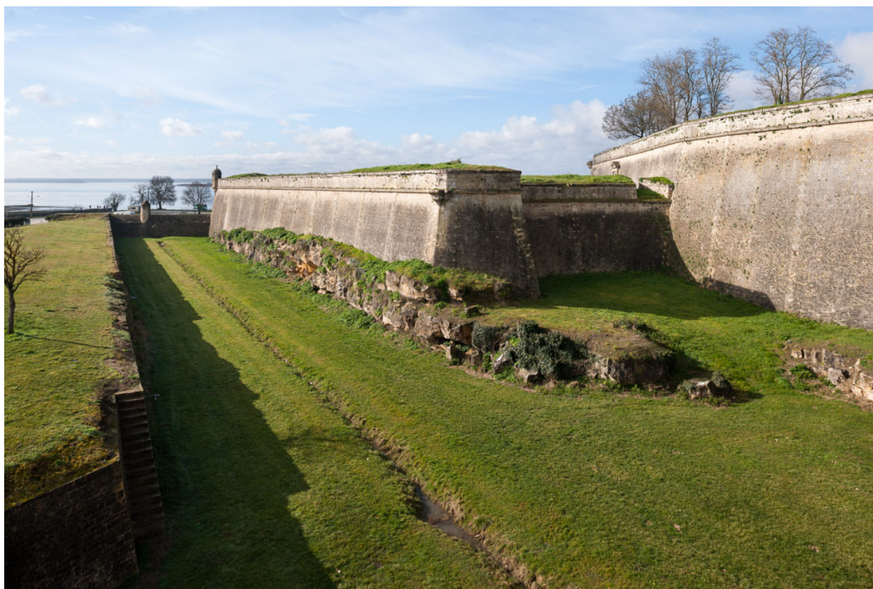
Vue d'ensemble du fossé et du bastion du port depuis le nord-est.
