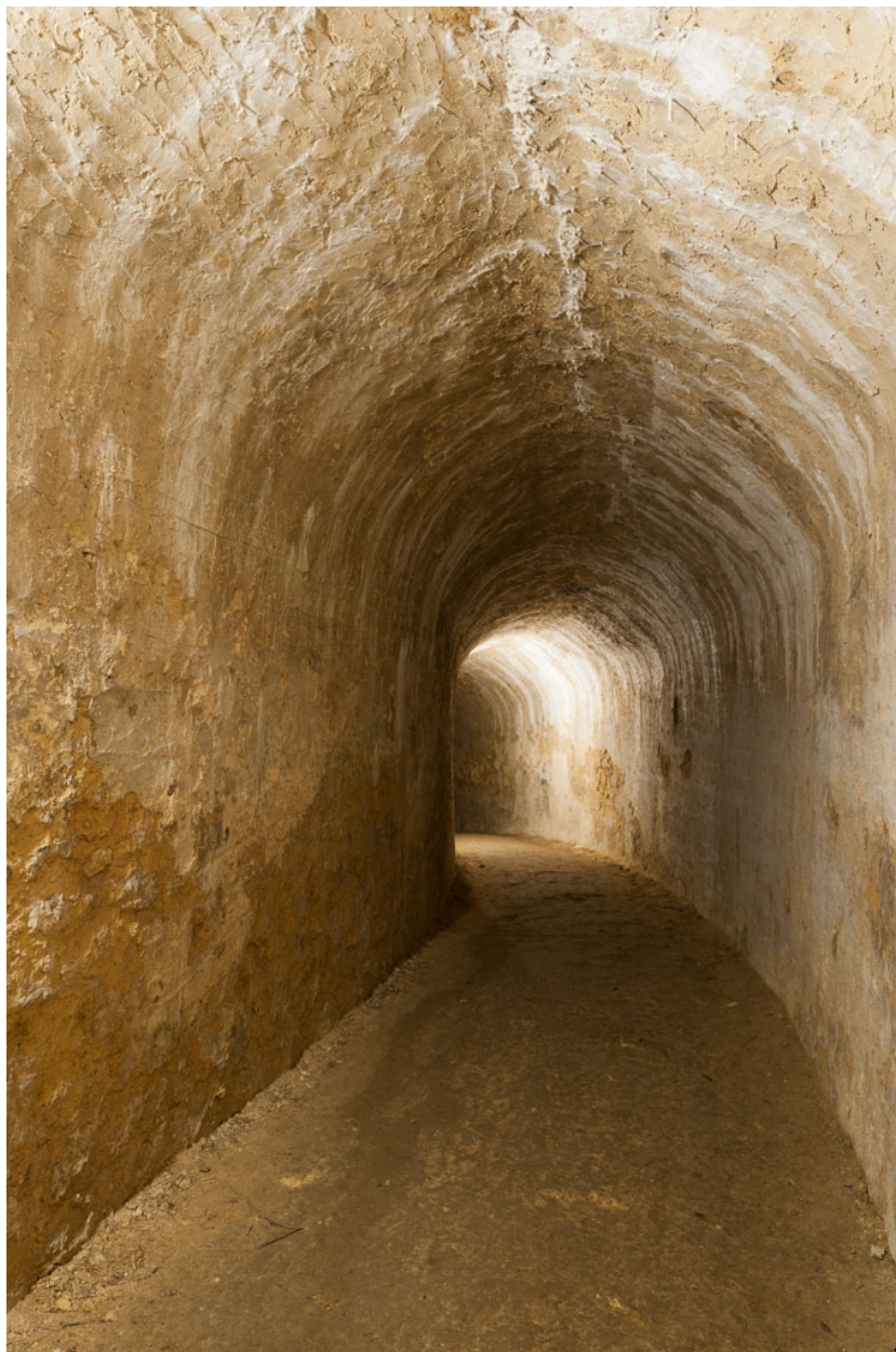
Couloir souterrain de liaison entre la poterne du bastion du château et la fausse-braie du côté du front du Cône au nord.
