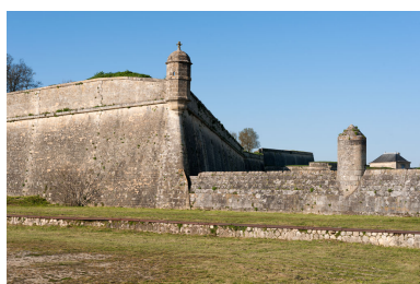
Vue du batardeau et du saillant du bastion du port depuis le sud. Phot. Adrienne Barroche IVR72_20113310663NUC4A
