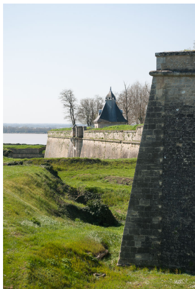
Saillant du cavalier du bastion Saint-Romain avec la porte dauphine à l'arrière-plan. Phot. Adrienne Barroche IVR72_20113310645NUC4A
