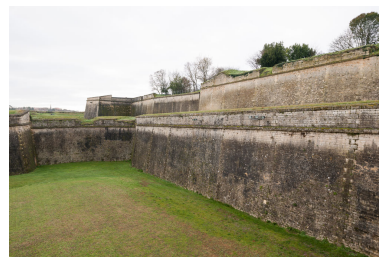
Courtine et flanc nord du bastion du port. Phot. Adrienne Barroche IVR72_20113310692NUC4A
