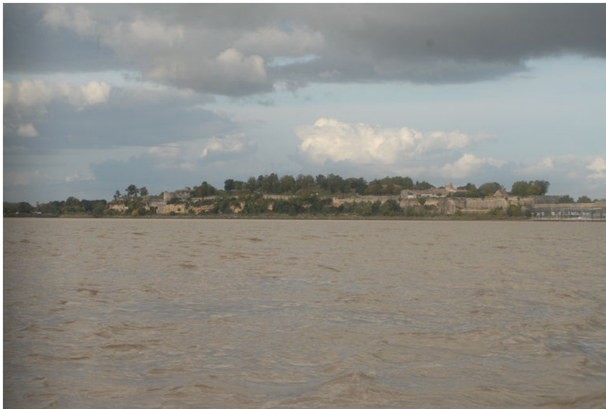
Vue du site depuis le chenal de la Gironde.
