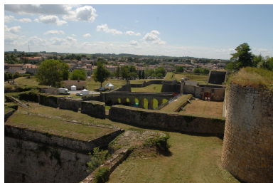
Vue sur le flanc est depuis la tour des Rondes. Phot. Michel Dubau IVR72_20093300175NUC2A
