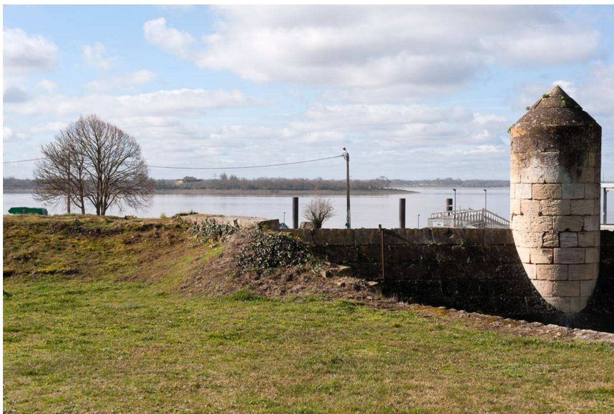
Batadeau sur le fossé du bastion du port : détail de la dame.
