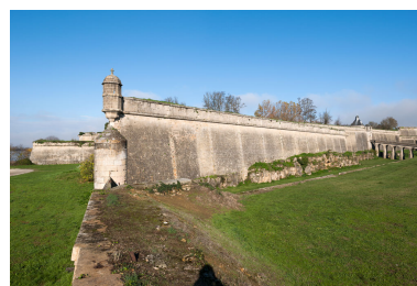
Front ouest du bastion du port et front de la citadelle face à l'estuaire. Phot. Adrienne Barroche IVR72_20113310666NUC4A
