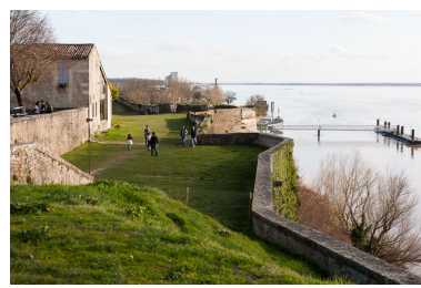
Vue vers le sud depuis le chemin de ronde du secteur du couvent des Minimes. Phot. Adrienne Barroche IVR72_20113310770NUC4A
