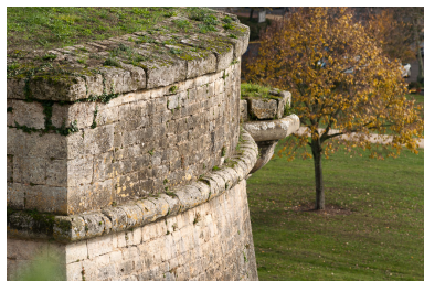
Bastion Saint-Romain : détail de l'orillon sud. Phot. Adrienne Barroche IVR72_20113310679NUC4A
