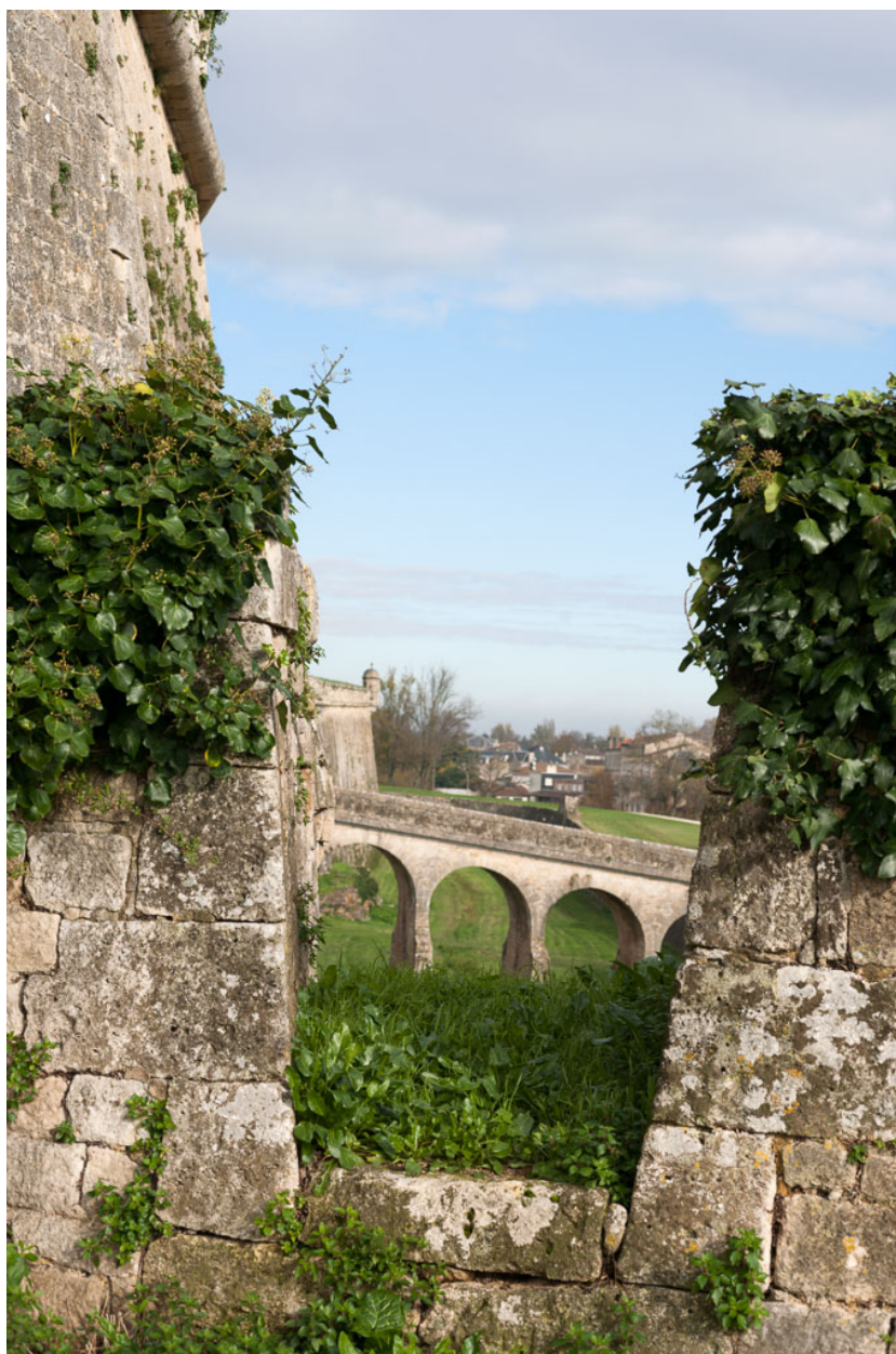
Vue depuis le bastion du port vers le nord.
