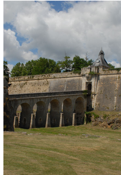
Pont sur le fossé face à la porte dauphine, vu du nord. Phot. Michel Dubau IVR72_20093300193NUC2A
