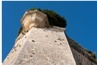
Saillant face à l'estuaire de la batterie dite des matelots : détail. Phot. Adrienne Barroche IVR72_20113310804NUC4A
