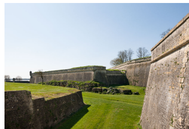
Vue de la partie de la demi-lune de la porte dauphine, fossé et bastion du port depuis le nord-est. Phot. Adrienne Barroche IVR72_20113310652NUC4A
