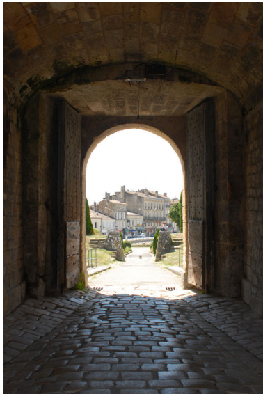
Vue depuis le corps de passage de la demi-lune de la porte dauphine vers la ville. Phot. Michel Dubau IVR72_20093300200NUC2A
