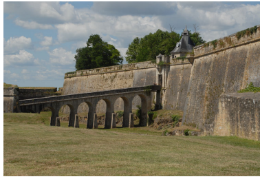
Pont sur le fossé face à la porte dauphine, vu du nord. Phot. Michel Dubau IVR72_20093300191NUC2A
