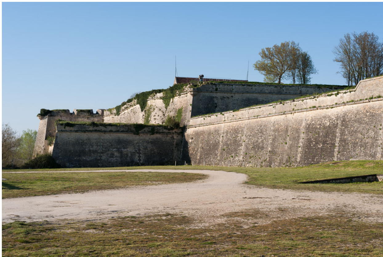
Front ouest du bastion du port et de la citadelle face à l'estuaire.
