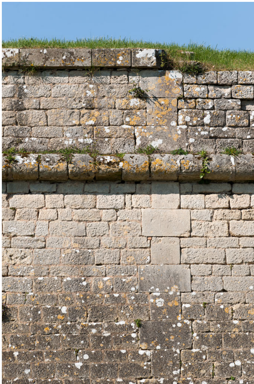
Bastion du château : front est, détail du parapet.
