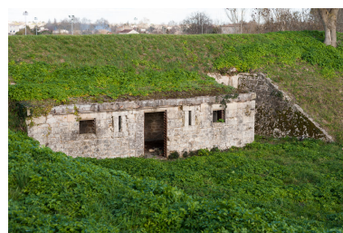
Bastion du Cône : corps de garde. Phot. Adrienne Barroche IVR72_20113310765NUC4A
