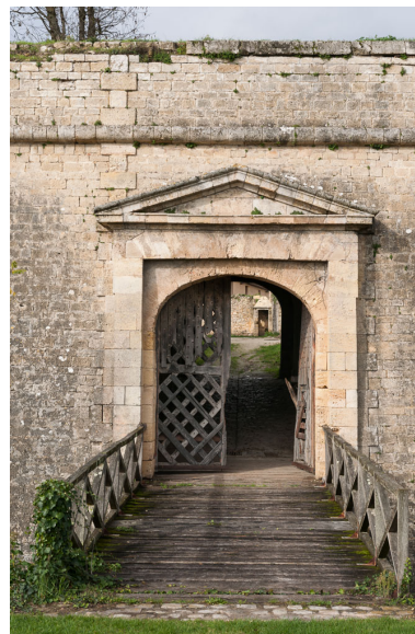
Bastion du Port : porte dans la courtine. Phot. Adrienne Barroche IVR72_20113310686NUC4A
