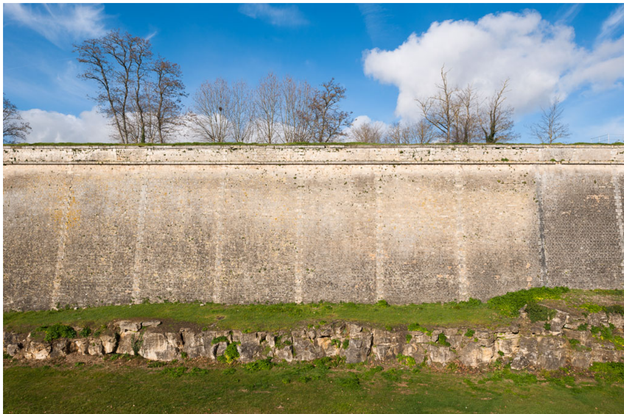
Courtine entre la porte dauphine et le bastion du port.
