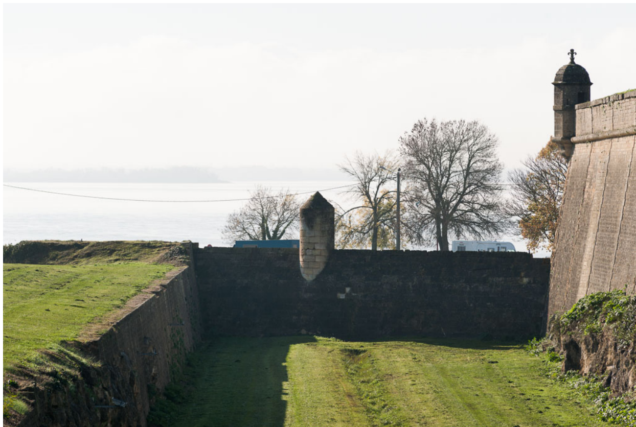
Batardeau sur le fossé du bastion du port.
