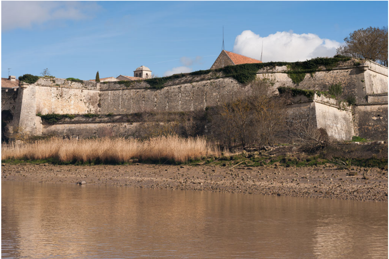
Vue du front sud-ouest face à l'estuaire, dit batterie des matelots.
