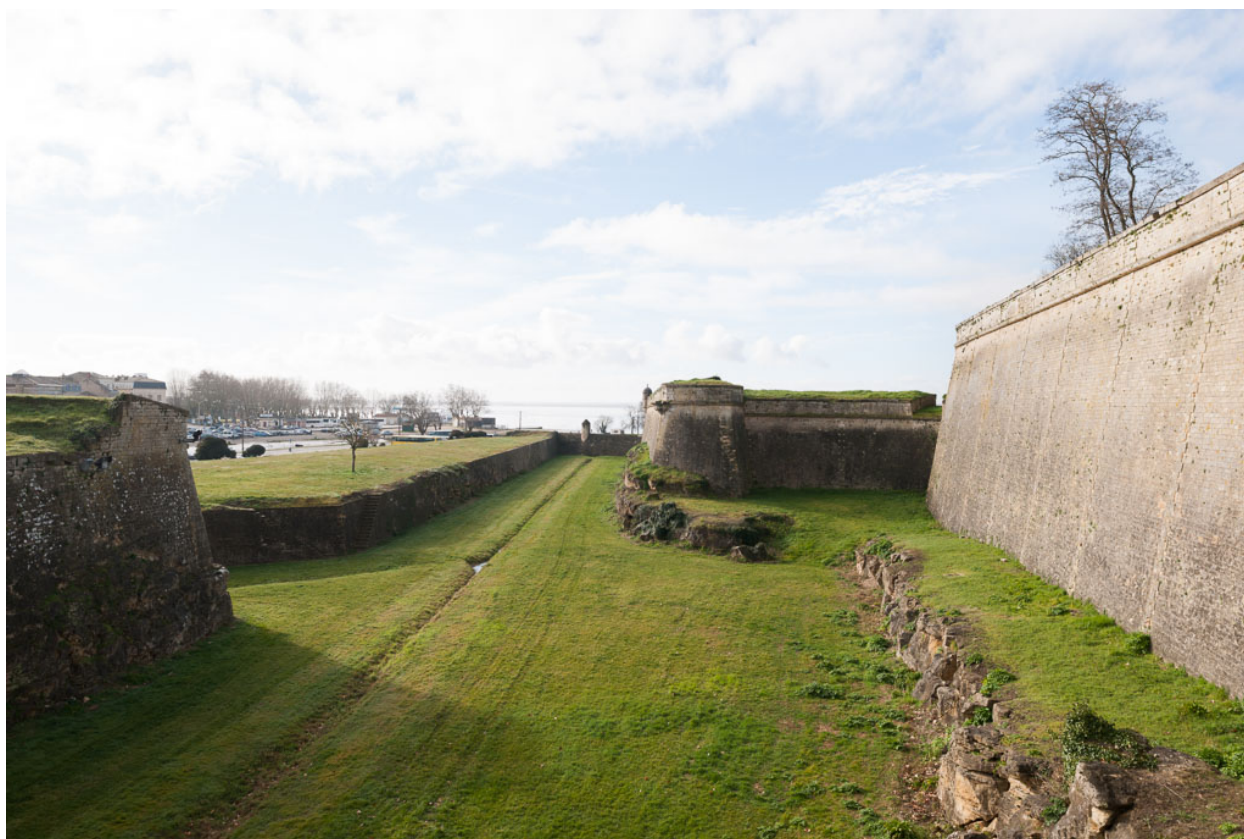
Vue de la courtine, du fossé et du bastion du port depuis le nord.
