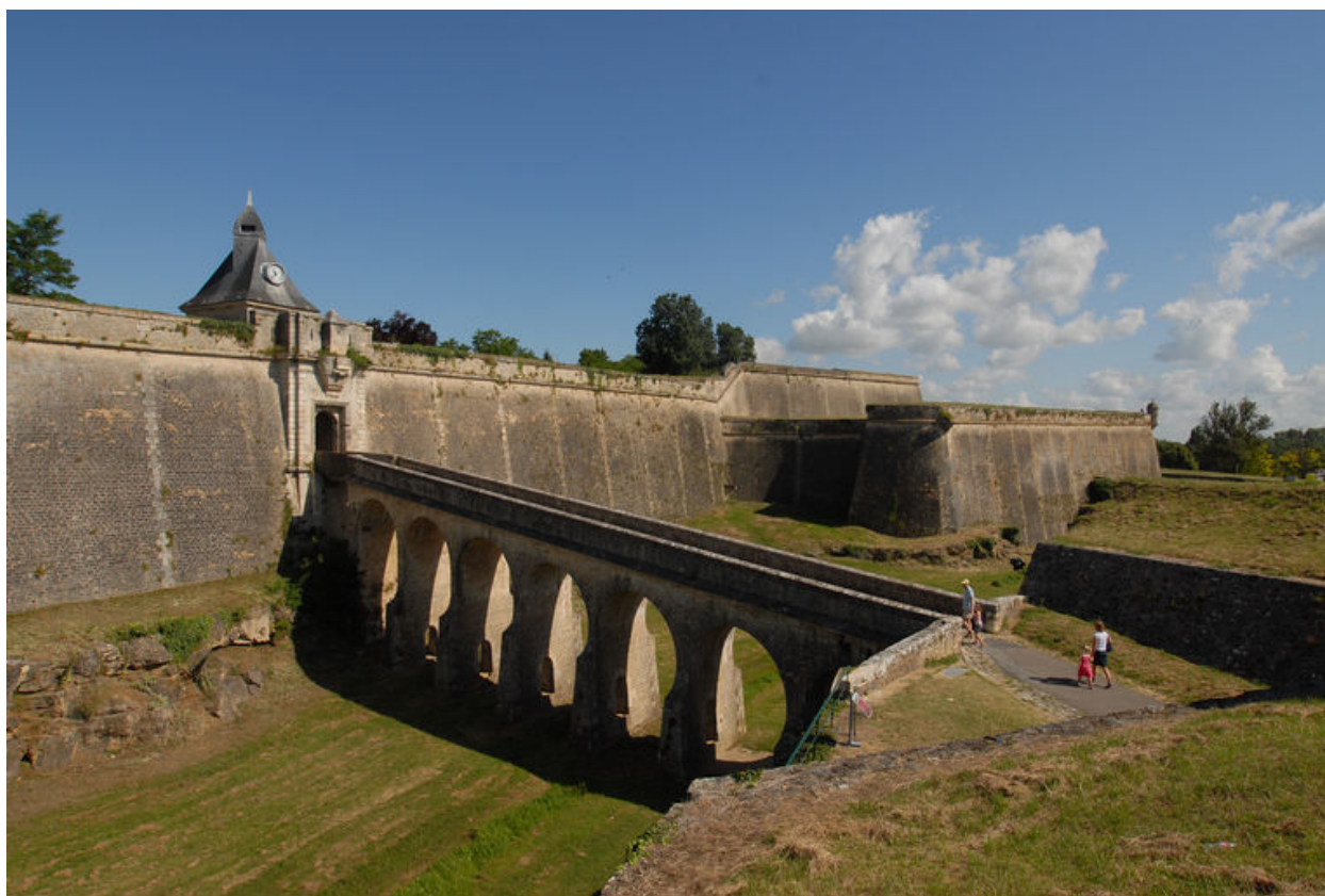
Pont sur le fossé et porte dauphine.
