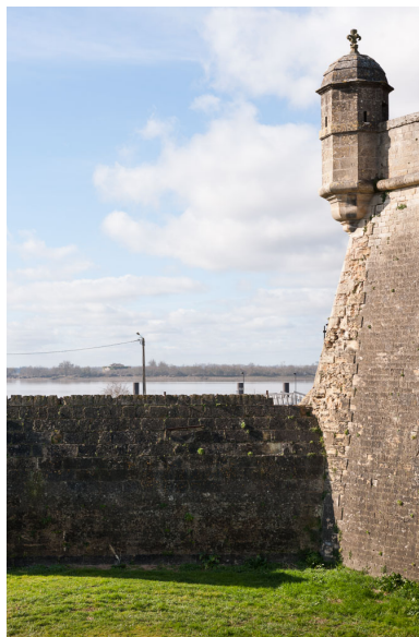
Batardeau et saillant du bastion du port. Phot. Adrienne Barroche IVR72_20113310659NUC4A
