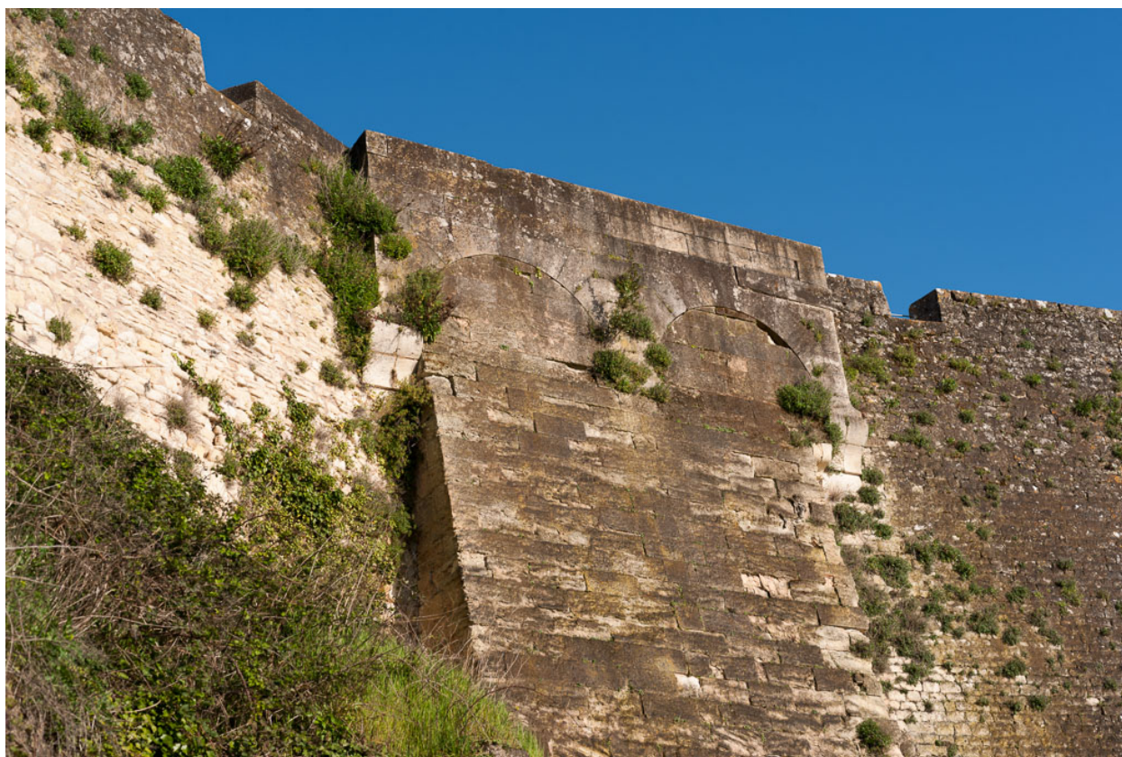
Front de la courtine face à l'estuaire, secteur sud-ouest : anciennes latrines.
