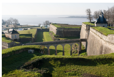
Vue de la demi-lune de la porte dauphine et du bastion du port depuis le bastion Saint-Romain au nord. Phot. Adrienne Barroche IVR72_20113310642NUC4A
