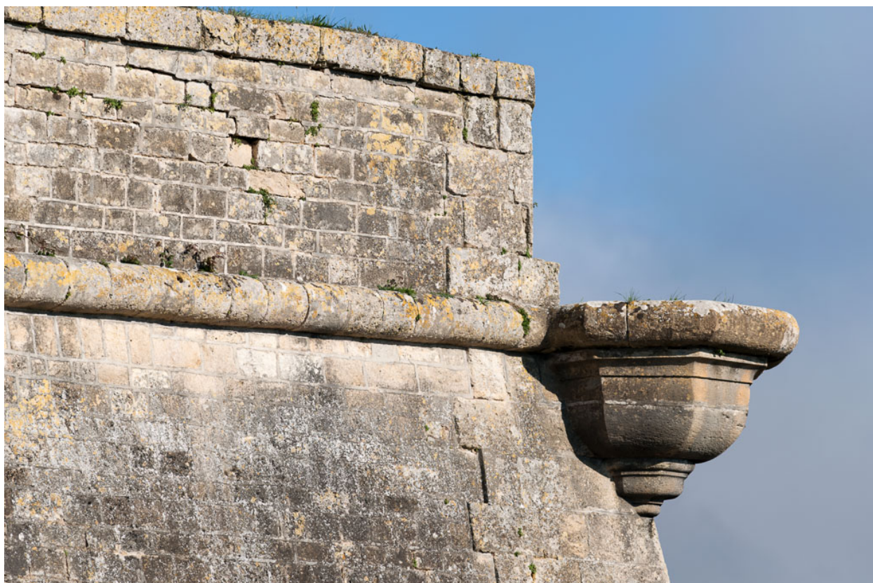
Bastion du port : détail de l'échauguette sur angle nord-est.
