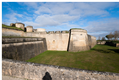
Vue d'ensemble de l'ouvrage avancé intégré dans le bastion, depuis le sud.
