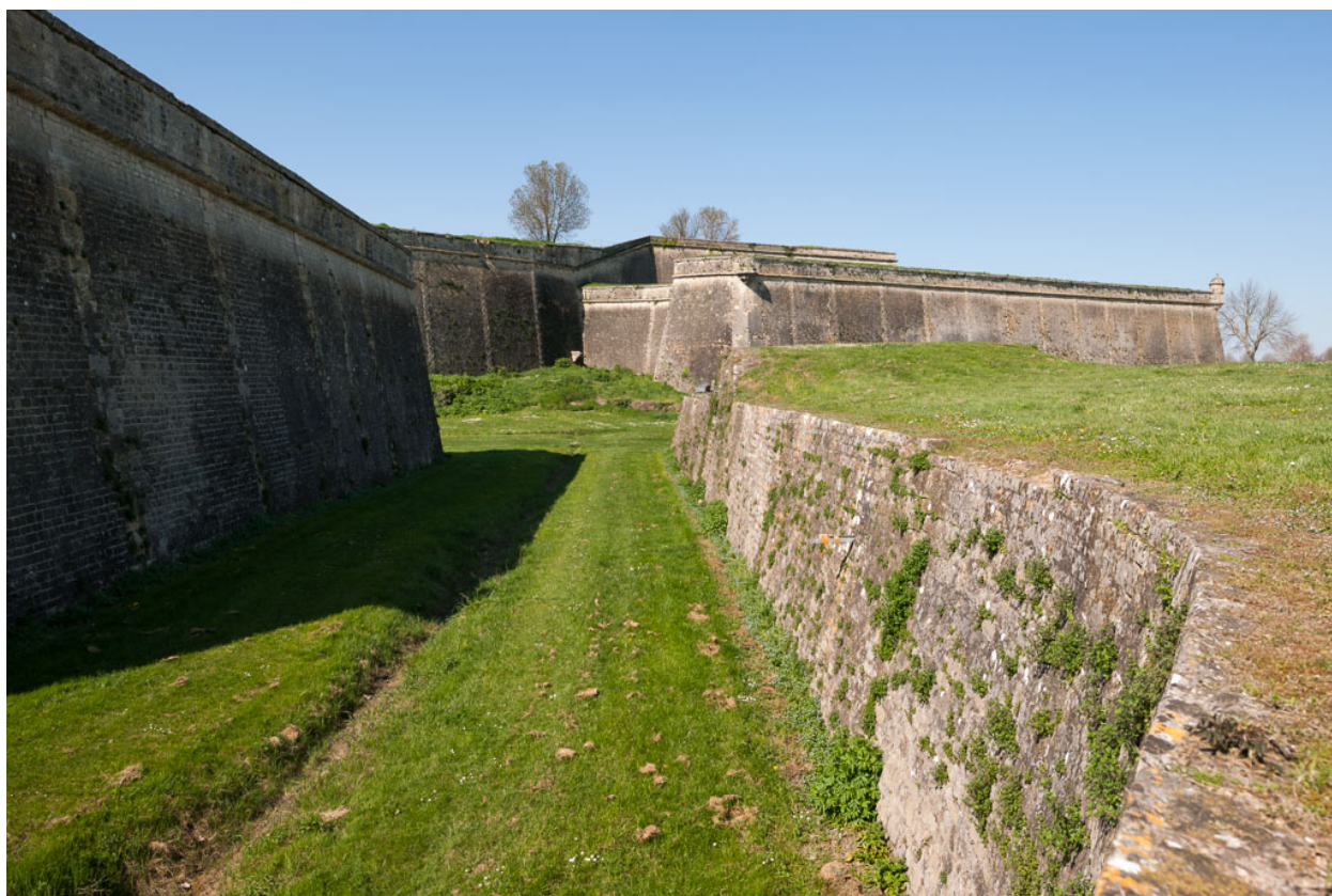
Vue du fossé de la demi-lune de la porte dauphine et bastion Saint-Romain depuis le sud.
