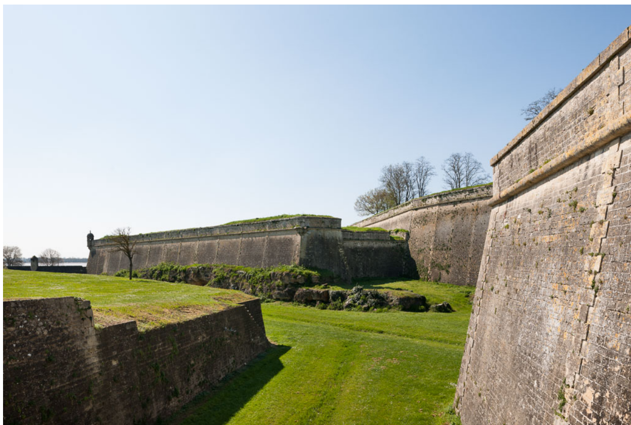
Vue de la partie de la demi-lune de la porte dauphine, fossé et bastion du port depuis le nord-est.
