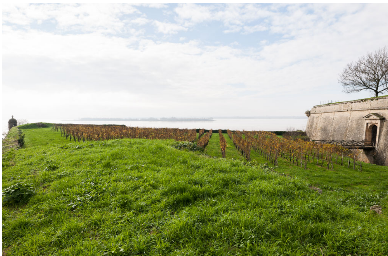
Bastion du port : terre-plein.
