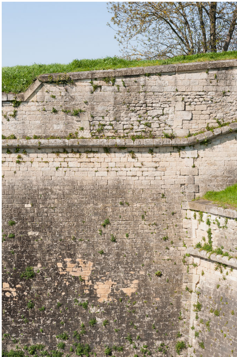
Détail de la courtine à l'angle sud du bastion Saint-Romain.
