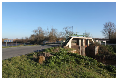
Pont de l'estey, côté amont avec pelles à crémaillère. Phot. Claire Steimer IVR72_20163301957NUC2A
