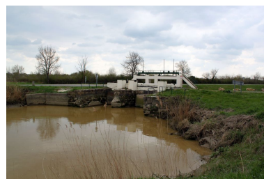
Pont de l'estey, côté aval avec portes à flots. Phot. Claire Steimer IVR72_20163301960NUC2A
