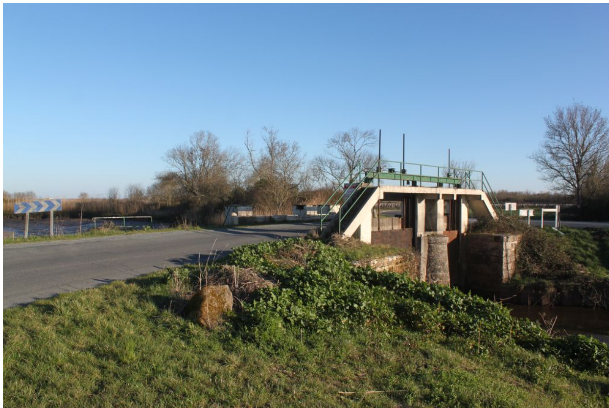
Pont de l'estey, côté amont avec pelles à crémaillère.
