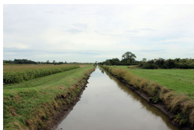
Vue depuis le pont de la Calupeyre, vers l'ouest. Phot. Claire Steimer IVR72_20163301952NUC2A
