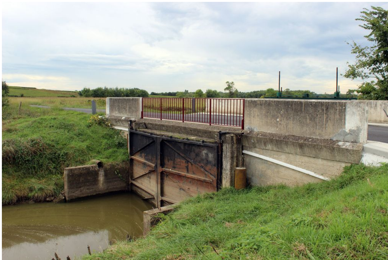
Pont de la Calupeyre avec porte à flots.
