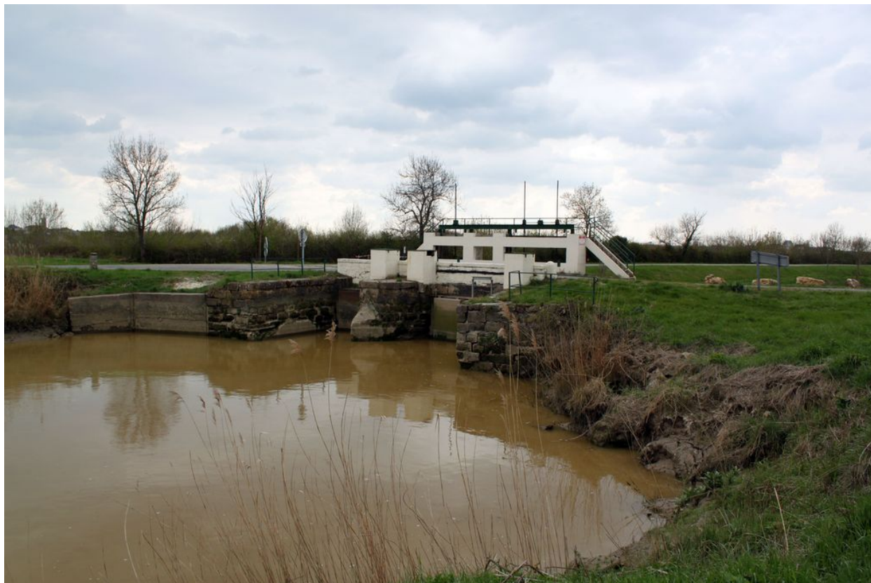
Pont de l'estey, côté aval avec portes à flots.
