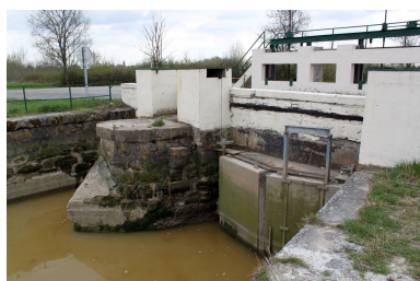
Pont de l'estey avec portes à flots. Phot. Claire Steimer IVR72_20163301959NUC2A
