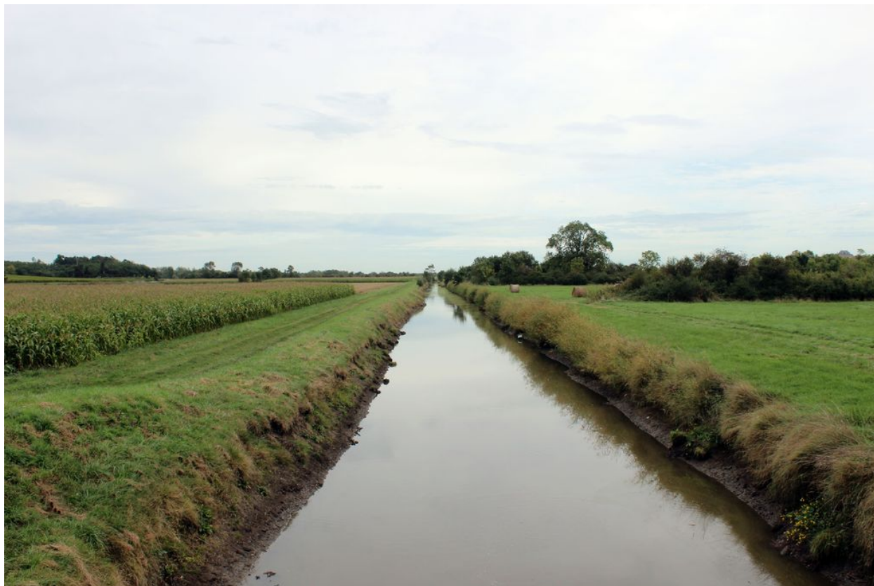
Vue depuis le pont de la Calupeyre, vers l'ouest.
