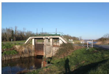
Pont de l'estey avec pelles à crémaillère. Phot. Claire Steimer IVR72_20163301955NUC2A
