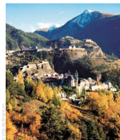
À Briançon, les fortifications ont façonné le paysage.
